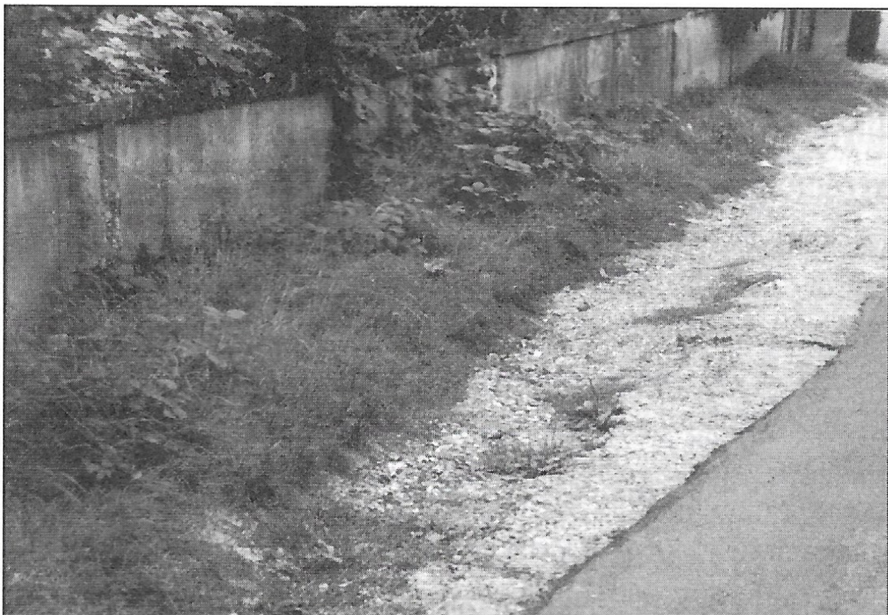
On imagine que l'aménagement initial prévoyait une bande de grave longeant une bande enherbée. Le résultat est douteux puisque chacun des deux revêtement a perdu son aspect d'origine.
