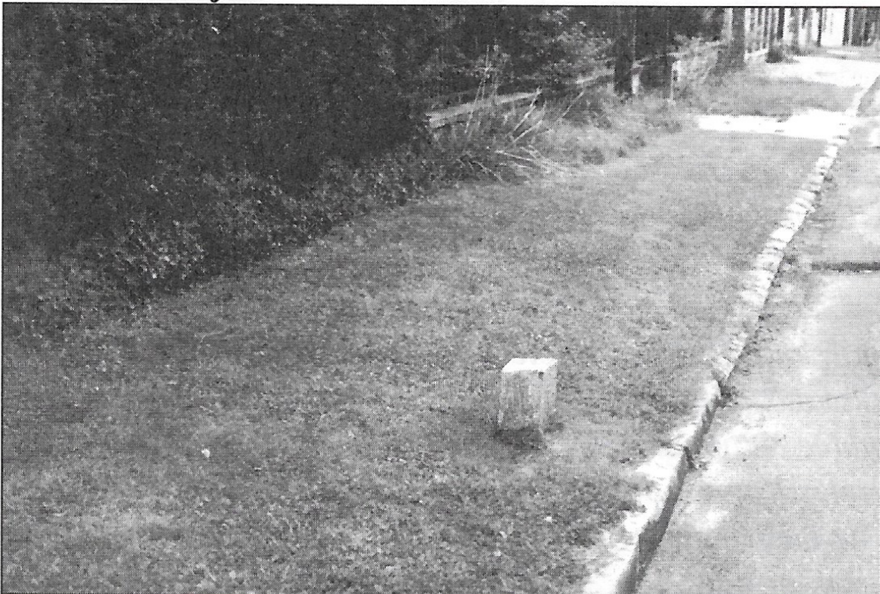
Le trottoir est enherbé, le gazon nécessite un entretien régulier : dès le printemps, 3 tontes mensuelles sont indispensables pour assurer le passage des piétons. L'emploi d'un désherbant n'est pas indispensable si l'on tolère un gazon "mêlé" et si les riverains débarrassent leurs murets des herbes hautes qui échappent à la tonte et qui peuvent rapidement investir la pelouse.
