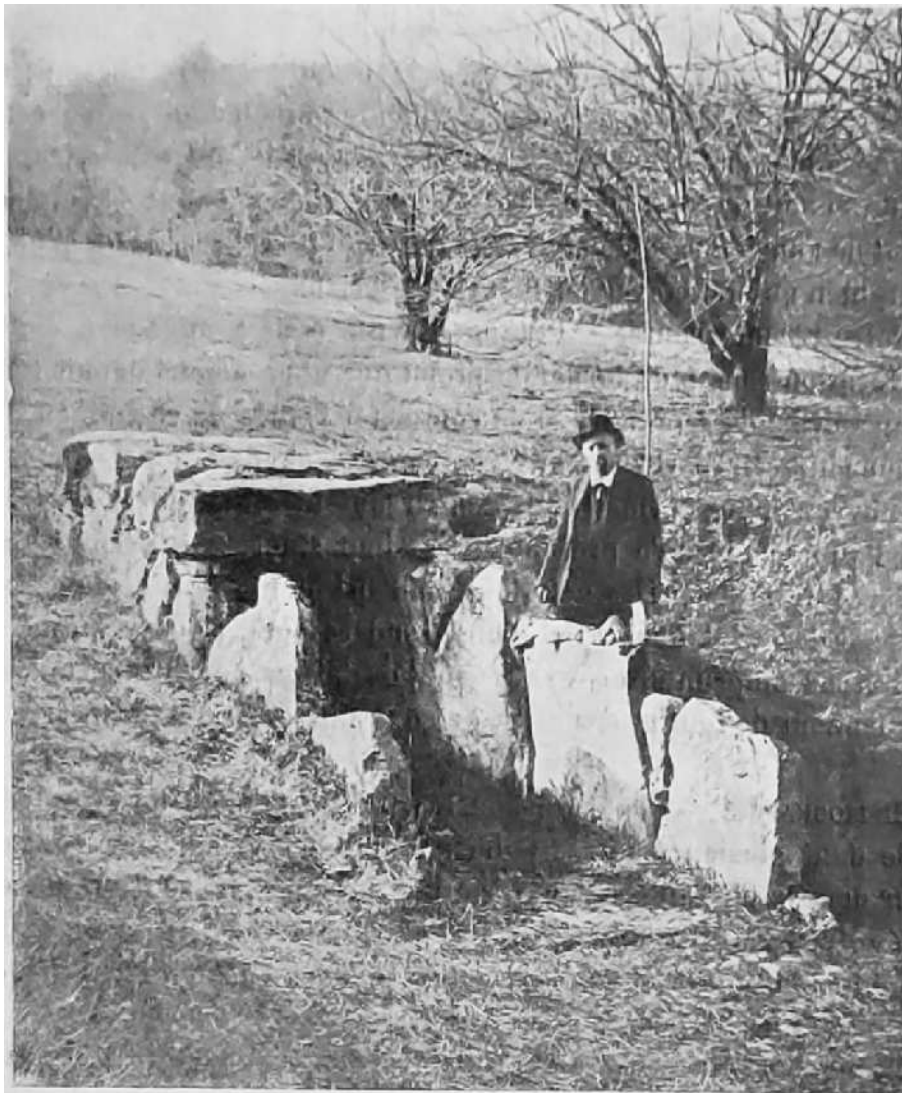
Fig. 1. — Dolmen de l'Étang-la-Ville. État actuel. Vue prise du Sud. — D'après une photographie d'Émile Deschastres, 19 avril 1914.
